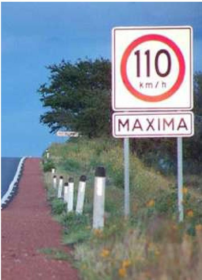
**FORMA:** El tablero de las señales restrictivas será de forma cuadrada con las esquinas redondeadas, excepto las de “ALTO”, que tendrá forma octagonal y “CEDA EL PASO”, que tendrá forma de un triángulo equilátero, con un vértice hacia abajo.
